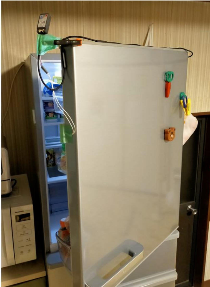
扉上部に設置
